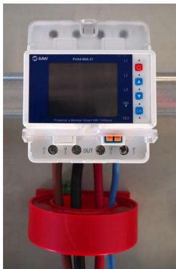
Para poder utilizar la protección por corriente de fuga deberá instalarse un transformador de corriente provisto junto al protector. En caso de no precisar dicha función, podrá obviarse su instalación.
