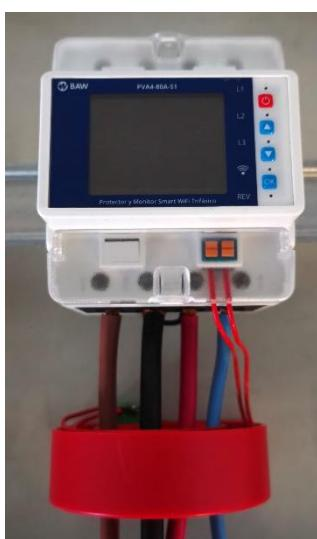
De esta manera quedará correctamente conectado el transformador de corriente y por lo tanto será posible utilizar la protección diferencial del protector trifásico Smart.
